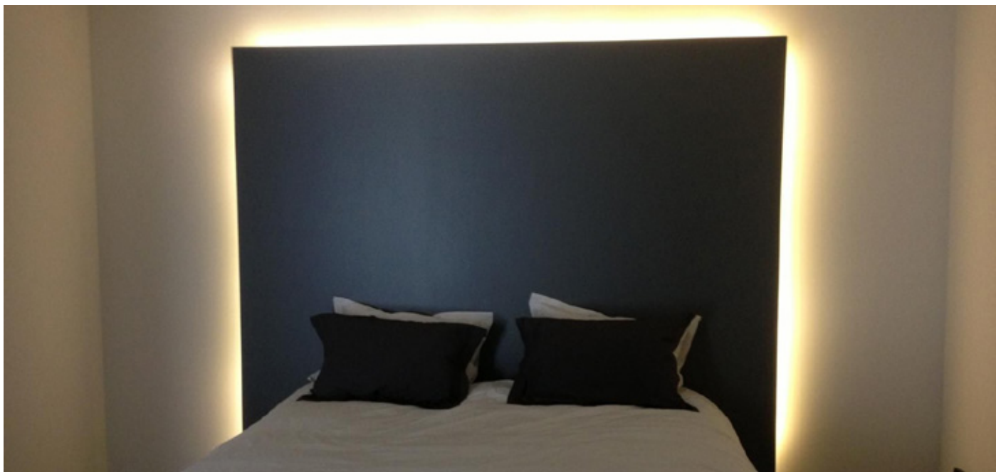
Eclairage indirect par corniche verticale côté tête de lit
