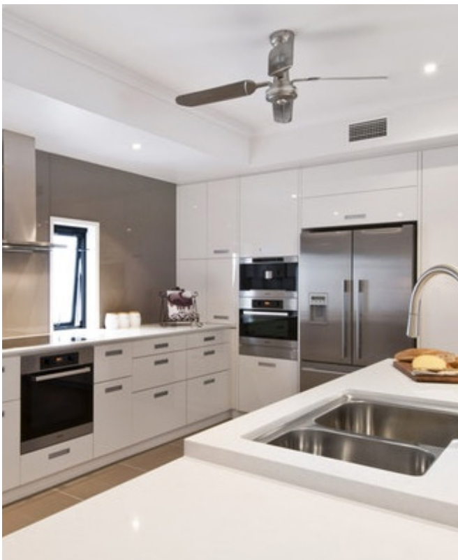
Caisson de plafond en décaissé + spots
