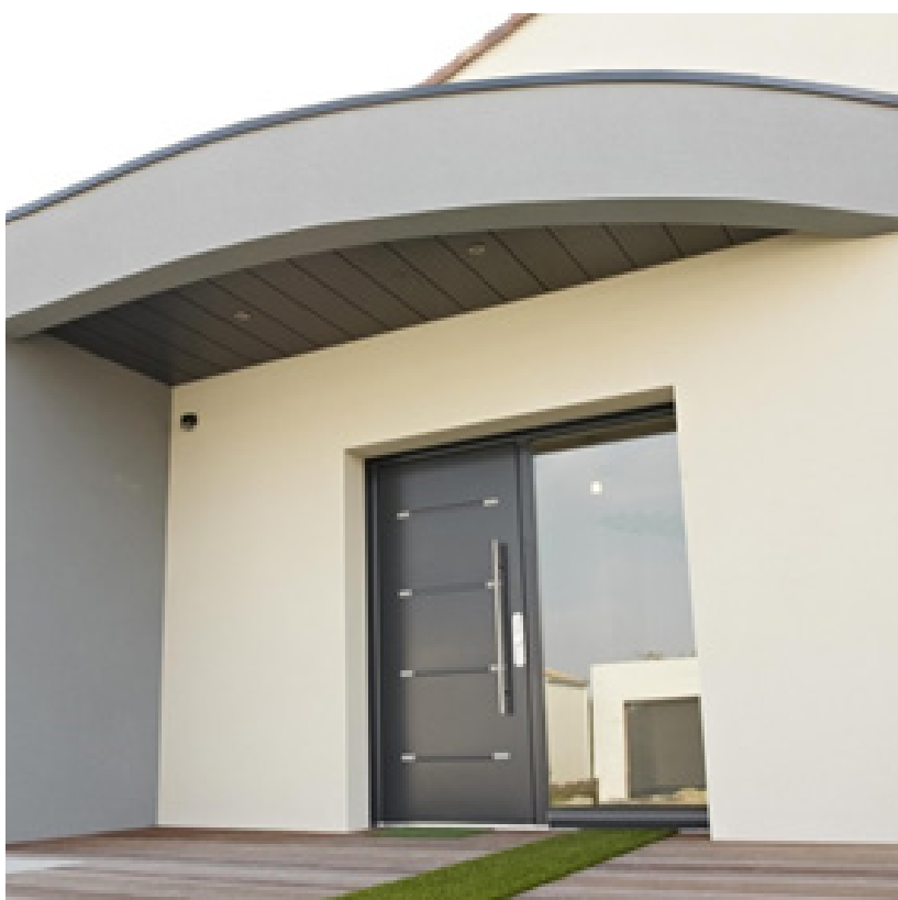
Porche sortant : mur d'1 mètre sur un côté de la porte, enduit, dalle ou deck, toiture dalle béton ou couverture avec ou sans sous-forêt.
