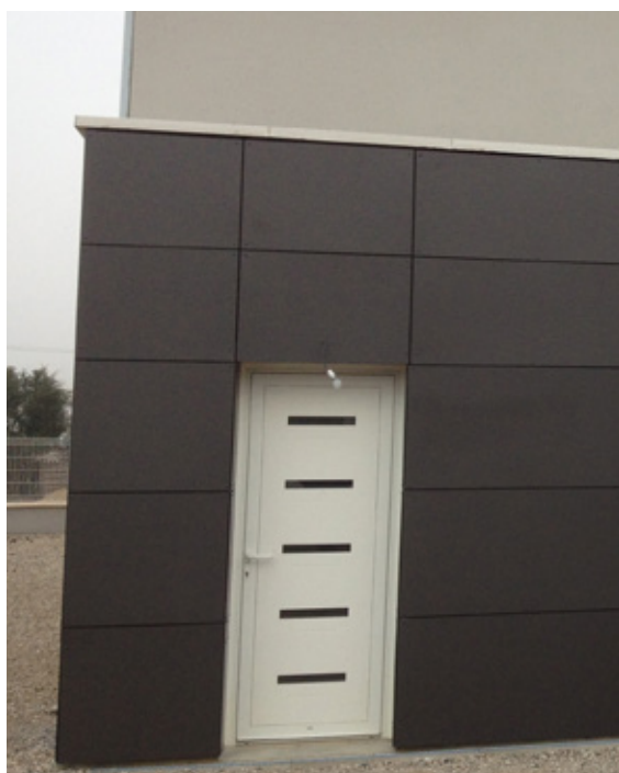
Habillage du porche en alucobond
